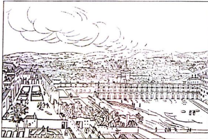
FIG. 207—ROMA. VISTA DEL PATIO DEL BELVEDERE.
