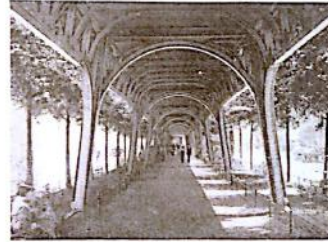
FIG. 842—BERLÍN. PASO PEATONAL BAJO VÍA FÉRREA ELEVADA.
