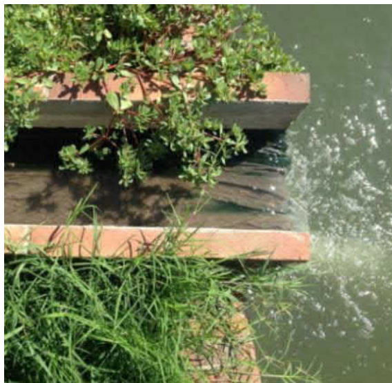
Figura 65 BCN04 Recuperación de los Canales de Aguas Termales, Provincia de Barcelona, España
