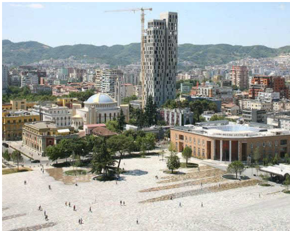
Figura 18 TIO1 Renovación de la Plaza Skanderbeg, Tirana, Albania
