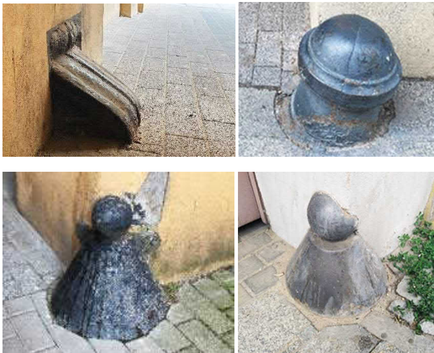
Figura 15 W Łodzi w bramach wielu kamienicach czynszowych zbudowanych na przełomie XIX i XX wieku zamontowano różne formy zabezpieczenia naroży. Są one chronione i konserwowane podczas prac modernizacyjnych i remontowych, ( fot. A. Klimko).
