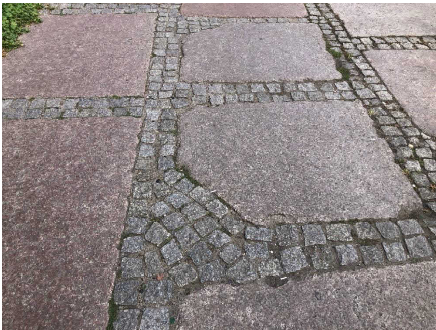
Figura 25 W zabytkowym centrum Szczecina podczas modernizacji masowo są wykorzystywane zachowane płyty chodnikowe. Ponownie układane są nawet częściowo uszkodzone płyty, ( fot. B. Szmygin).
