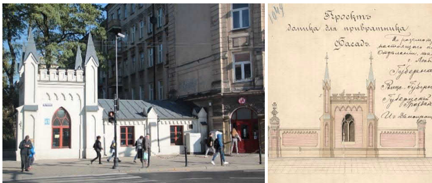
Figura 30 Historyczne ogrodzenia parku, neogotycka trójprzęsłowa, ażurowa brama żeliwna z kamiennymi filarami z latarnią. Integralnym elementem ogrodzenia jest Domek Odźwiernego zaprojektowany w 1889 r. przez Mariana Jarzyńskiego. Założenie ogrodowe wraz z elementami małej architektury zostało zrewaloryzowane i poddane konserwacji w roku 2011, ( fot. K. Boguszewska, źródło rysunku APL)
