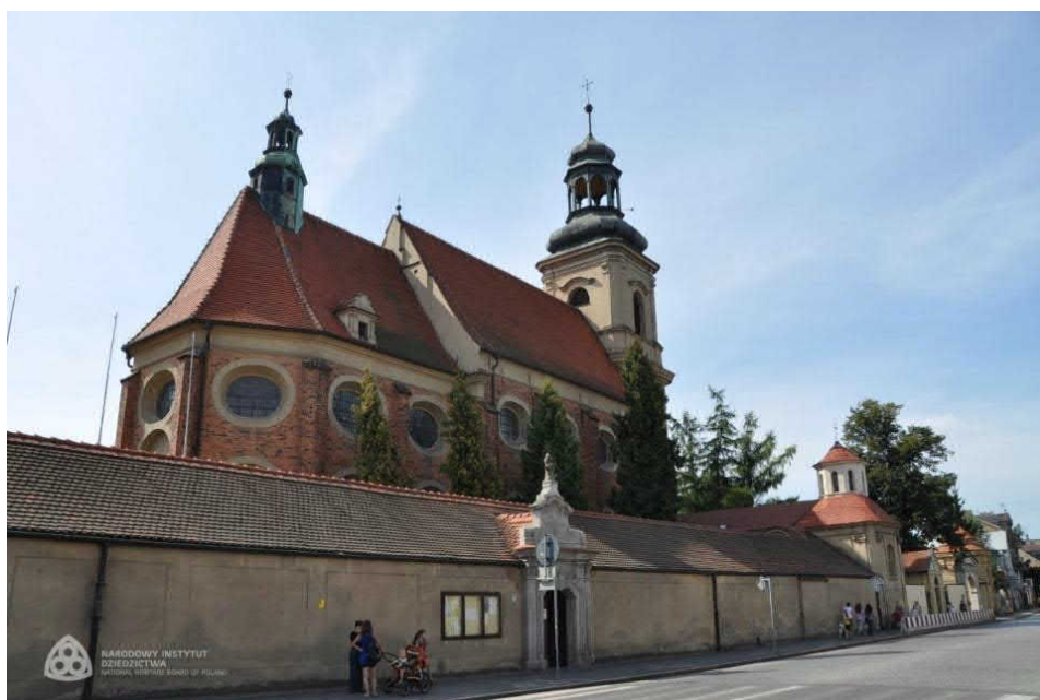
Figura 27 Wysoki, lity mur klasztorny we Wschowej – mur wykonany z kamienia, tynkowany, (źródło NID)
