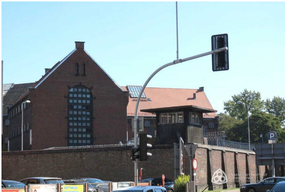
Figura 28 Wysoki, lity mur więzienny w Katowicach – mur ceglany, (źródło: NID)
