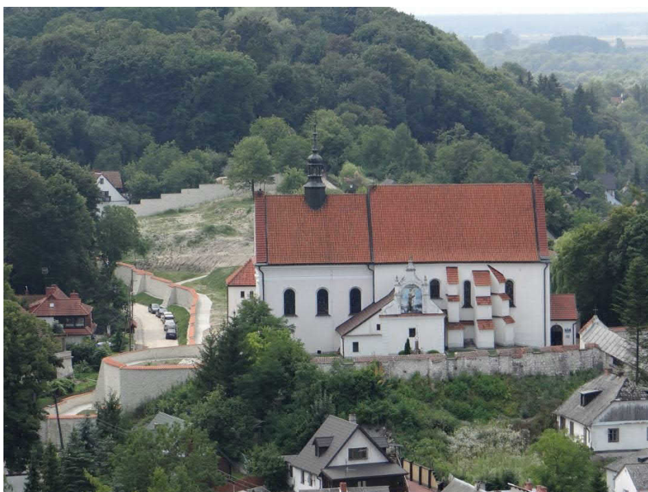
Figura 39 Ogrózenie zespołu klasztornego Franciszkanów Reformatorów w Kazimierzu Dolnym. Ogrózenie wykonano z lokalnego kamienia wapiennego, ( fot. J. Dyr., źródło: www.zabytek.pl )
