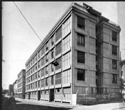
Viviendas de alquiler en via San Francesco, Novara (1957) junto con Ludovico Meneghetti y Giotto Stoppino
