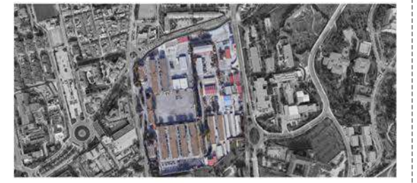
CUARTEL CERVANTES, GRANADA. (ESTADO ACTUAL)
