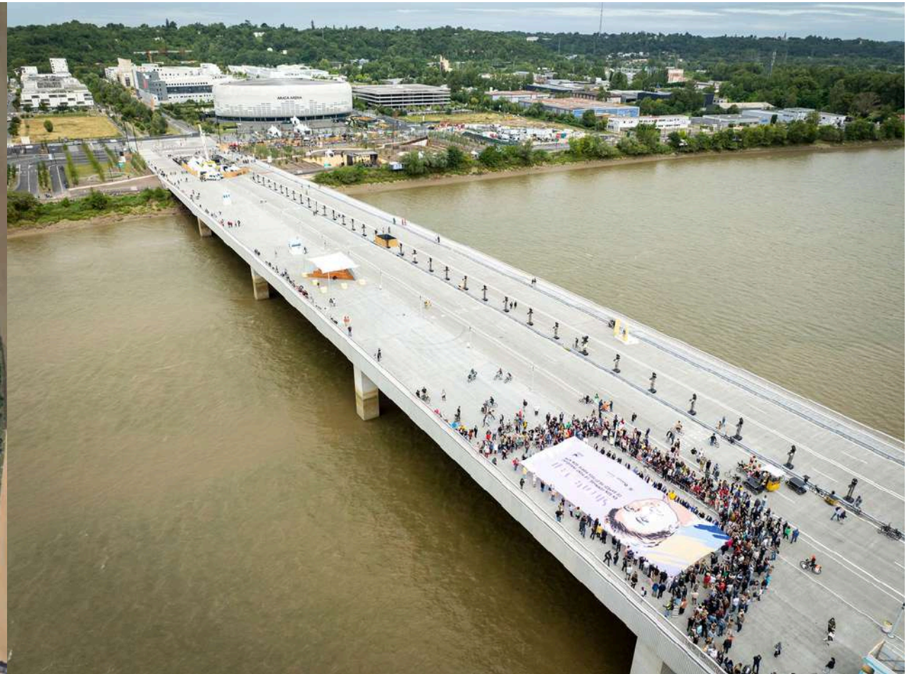
Puente Simone Veil
