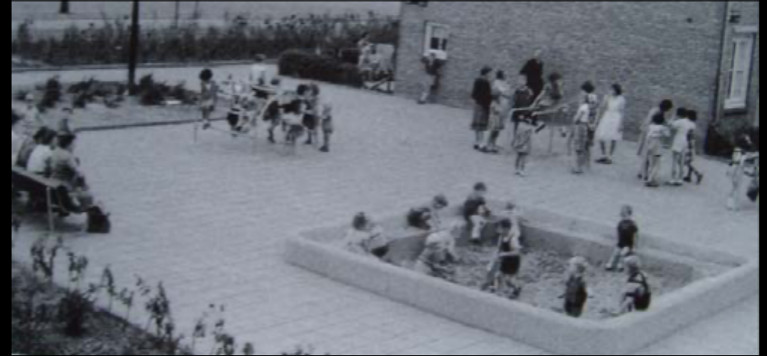
Nuevo foso de arena diseñado por Van Eyck con los bordes de hormigón
