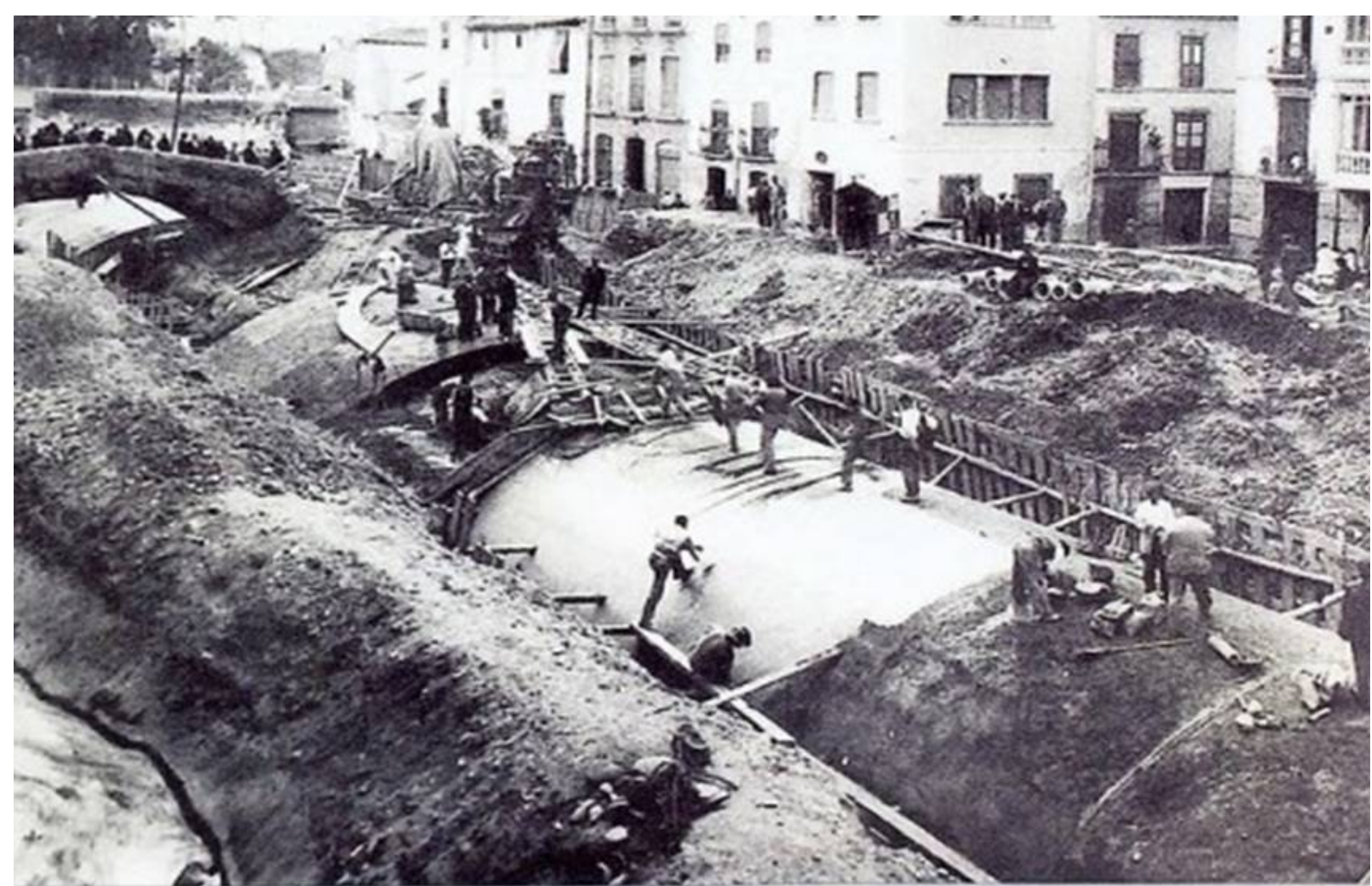
Trabajos Embovedado (Puente de la Virgen)
