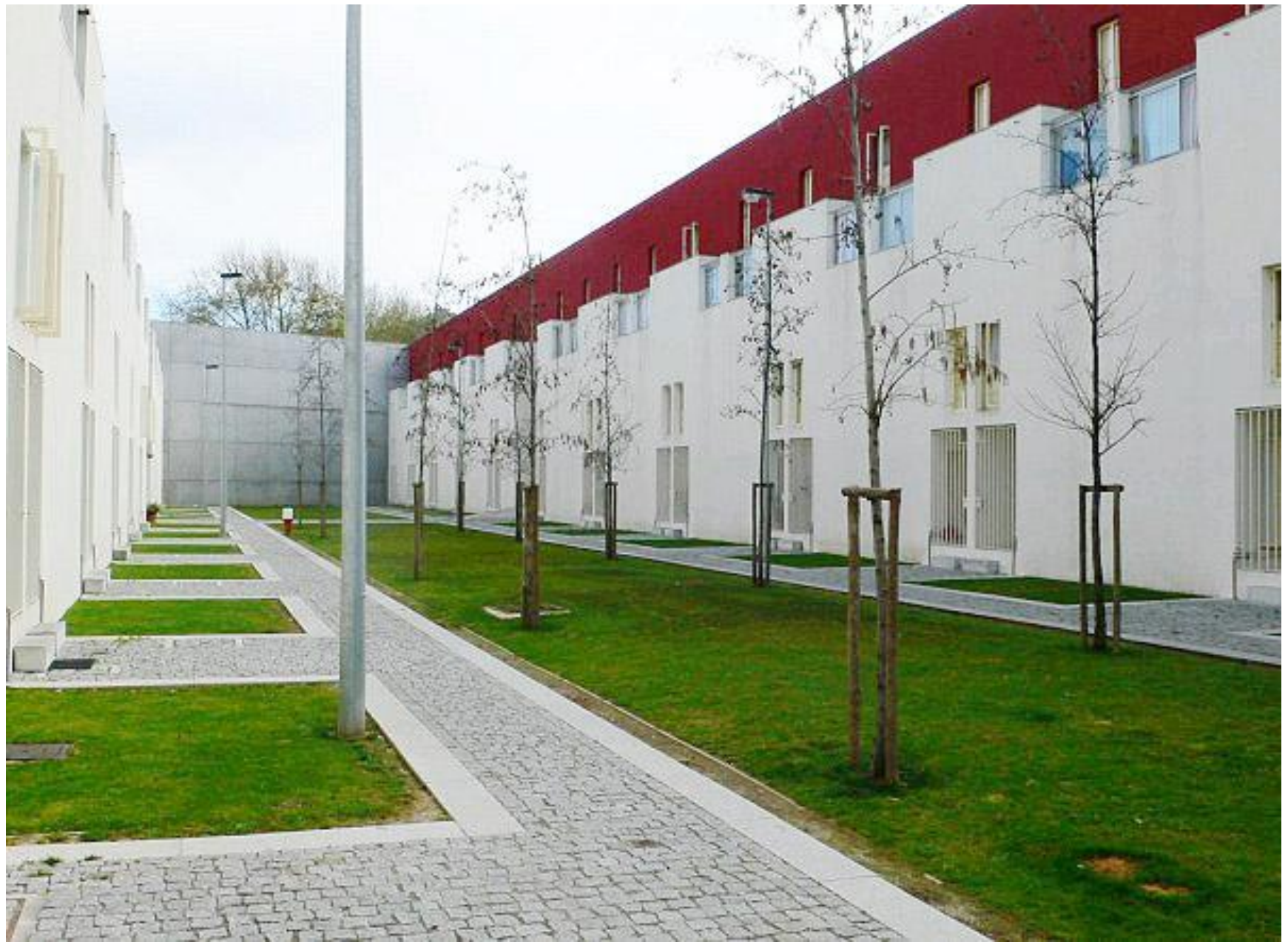
IMAGEN DE UNA DE LAS CALLES DE ACCESO A LAS UNIDADES
