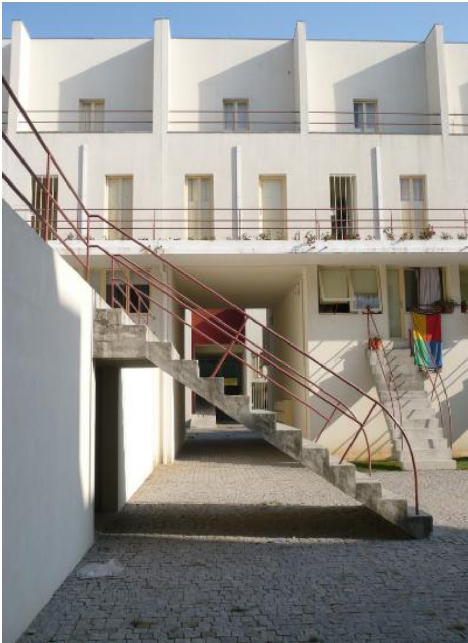
VISTA LATERAL DE UNA DE LAS ESCALERAS INDIVIDUALES
