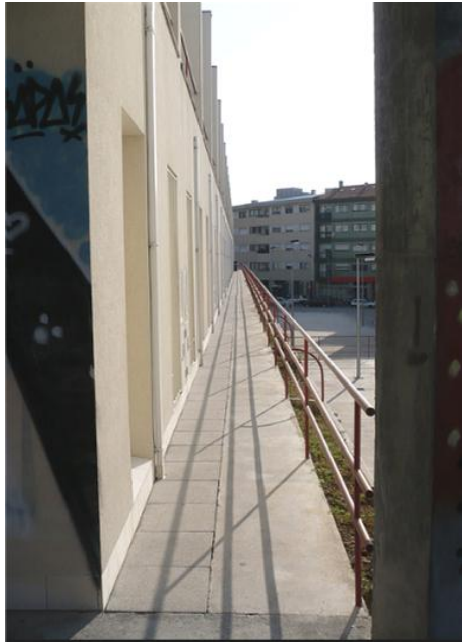
VISTA DE LA PASARELA CORRIDA DE PLANTA PRIMERA
