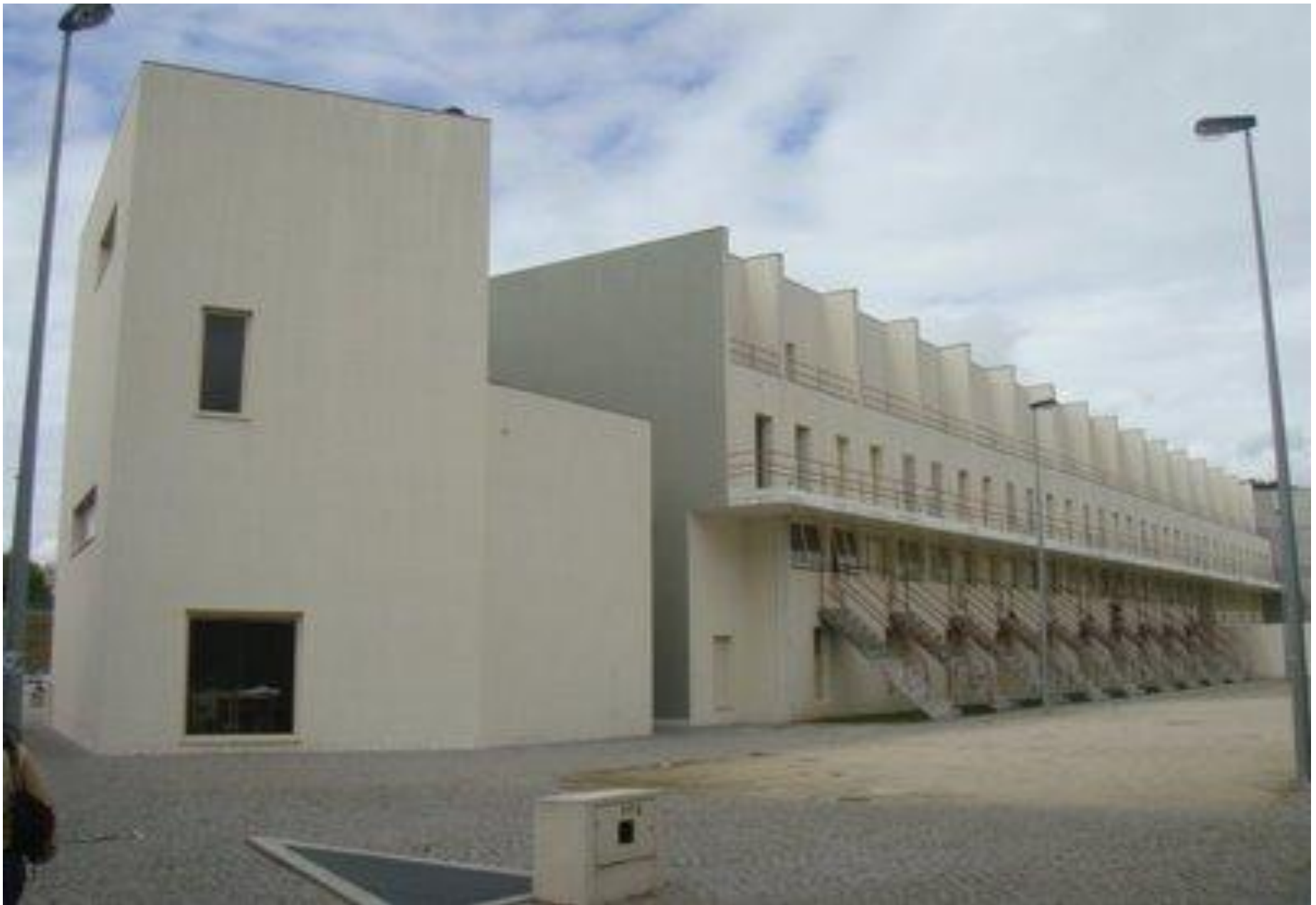
IMAGEN DE UNA DE LAS CALLES DE ACCESO A LAS UNIDADES
