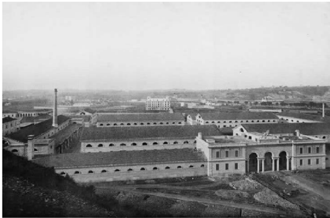
il Mattatoio in costruzione
