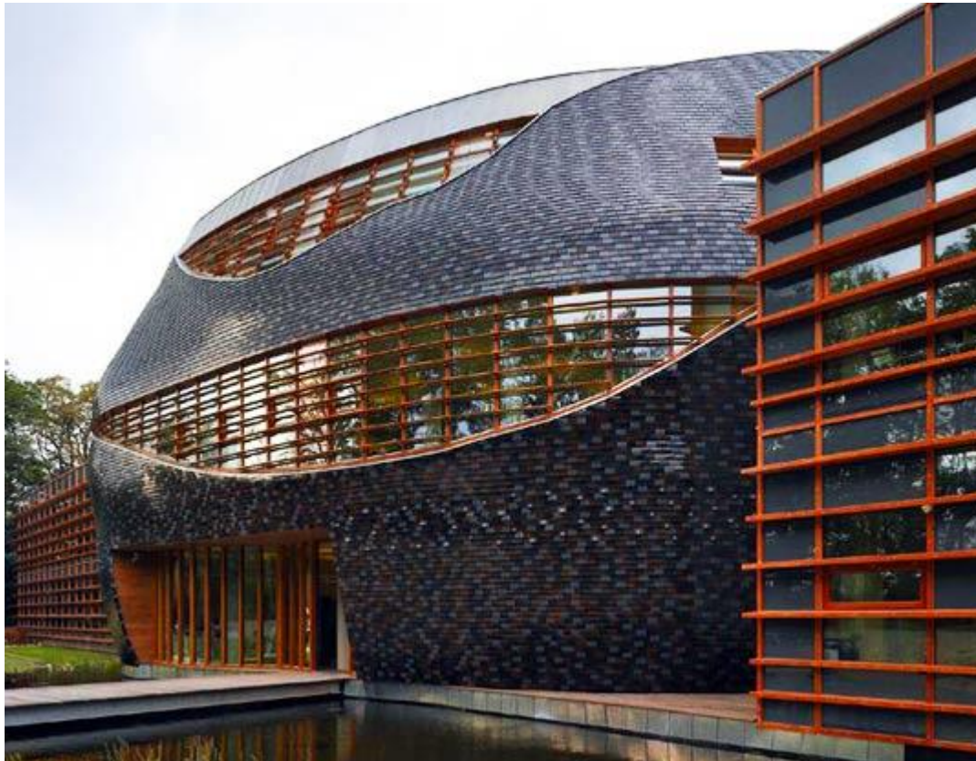
Edificio del complejo WWF (Países Bajos) de Thomas Rau que aprovecha la radiación solar
