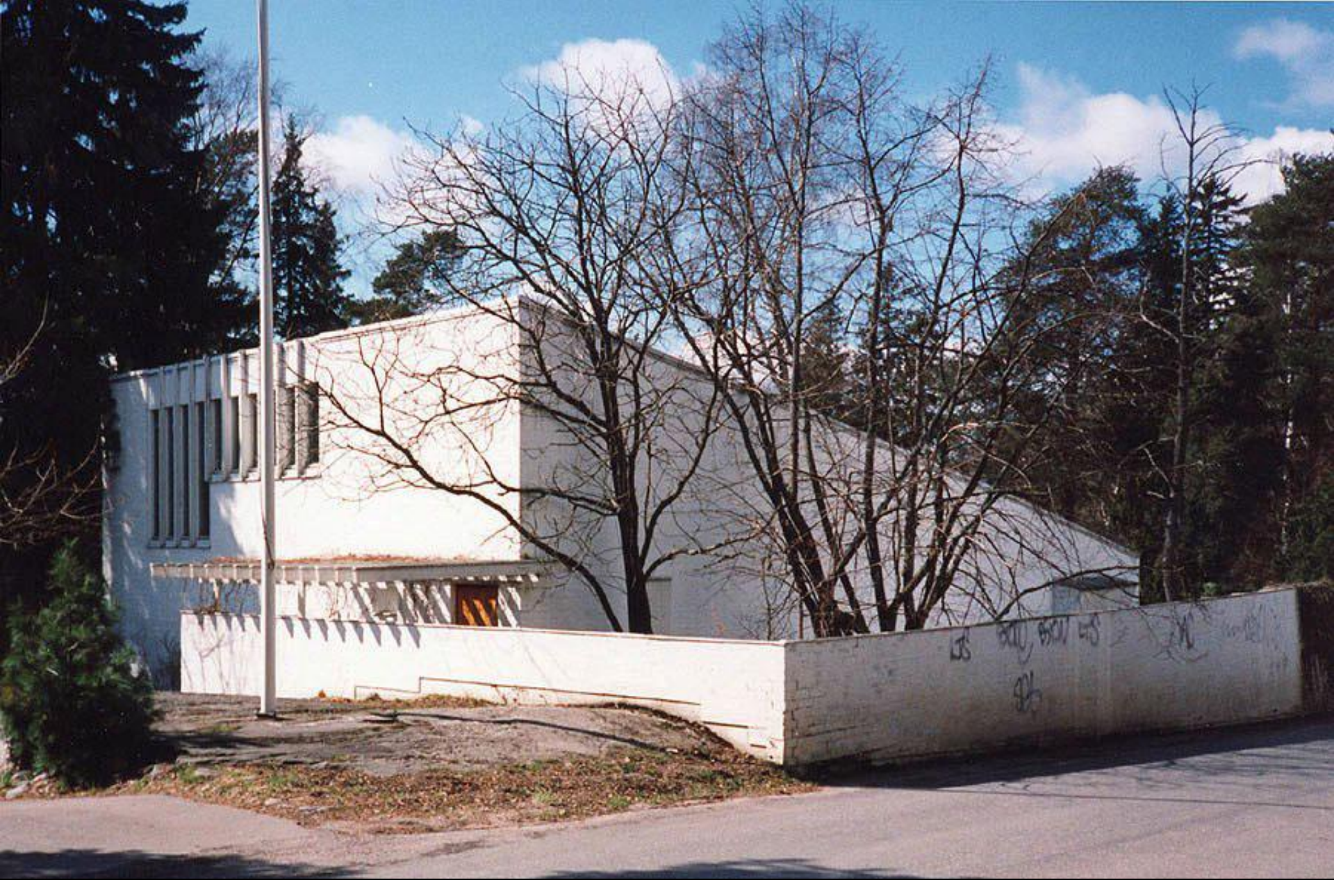
Vivienda experimental, Muuratsalo. 1952-53
