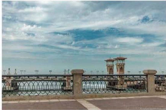
Stanley Bridge es el puente más icónico en el paseo marítimo de la Corniche.
